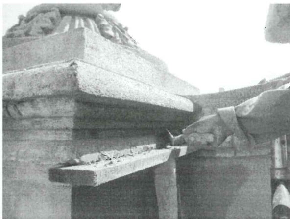
b. Proceso de la integración de repellos a base de cal en las molduras de los parapetos que rodean la azotea del Torreón Central
